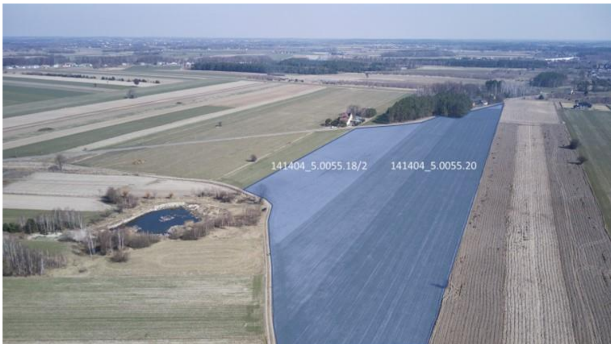
Rysunek 27. Widok terenu przyszłej inwestycji – na niebiesko zaznaczono schematycznie działki nr 18/2 i 20 (własne zdjęcie z drona)
