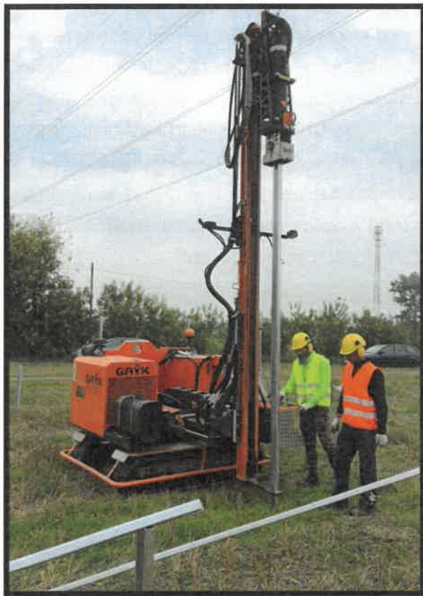
Zdjęcie 4 Montaż konstrukcji wsporczej (kafar)
