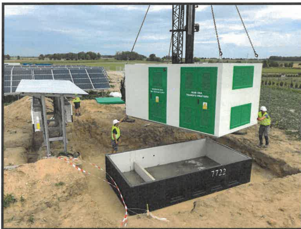
Zdjęcie 5 Posadowienie stacji transformatorowej
